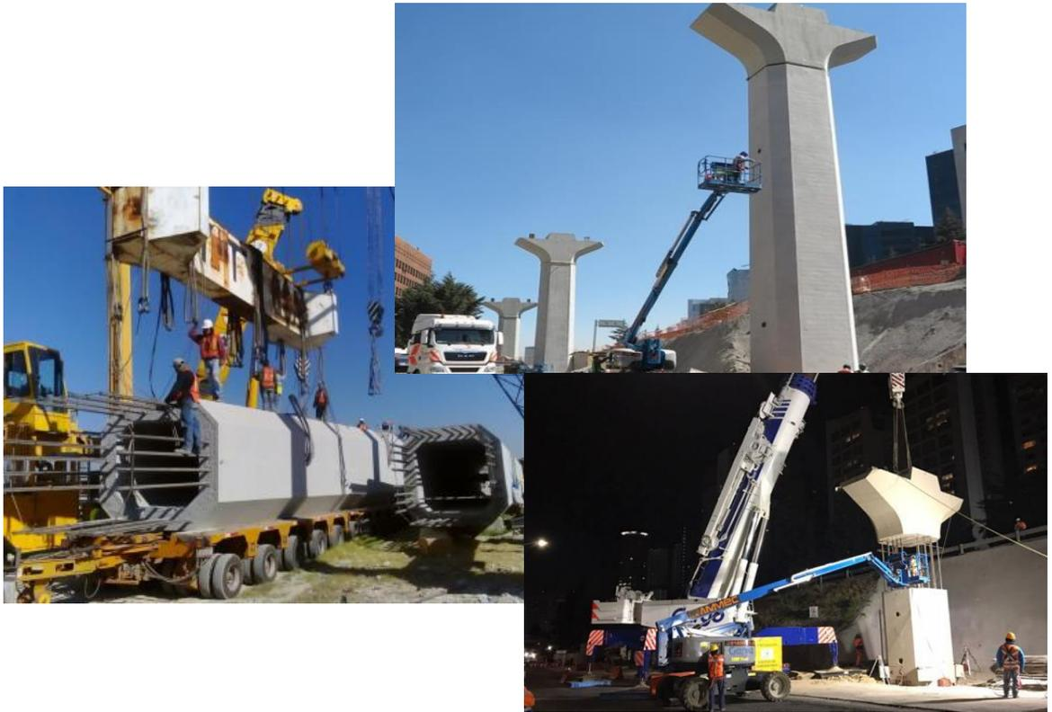
COLUMNA PREFABRICADA VIADUCTO ELEVADO
